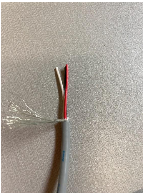
カッターナイフでケーブルの皮むき（シース）作業
