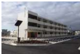
【敷地北東からの全景】
