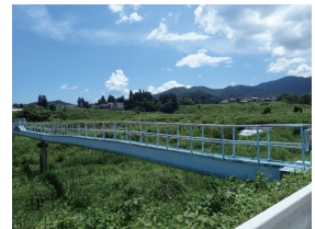
【農業用水を送水する水管橋】
