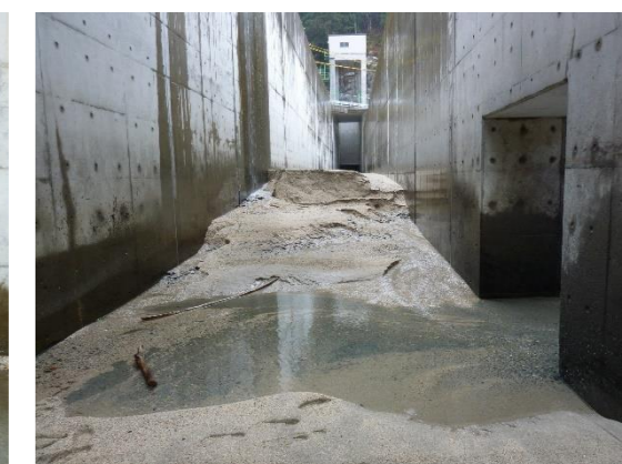
オリフィスゲート上流側からトンネル呑口(下流側)に向かって撮影
