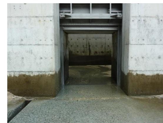
オリフィスゲート付近の様子
