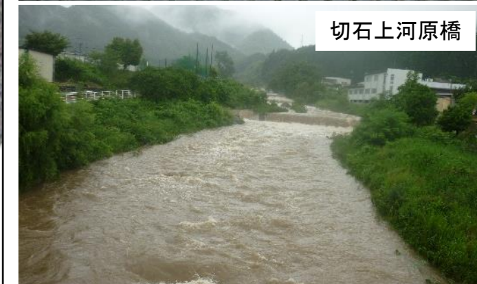
出水中の様子 (H30.7.5 10時頃撮影) 全放流量: 35.83m 3 /s バイパス主ゲート放流量 35.27m 3 /s
