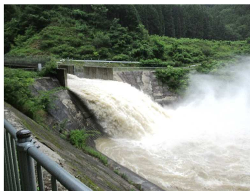
H30.7.4 バイパス放水路の状況
