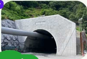
狸平トンネル
