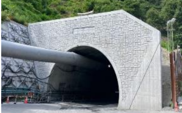
トンネル現場
