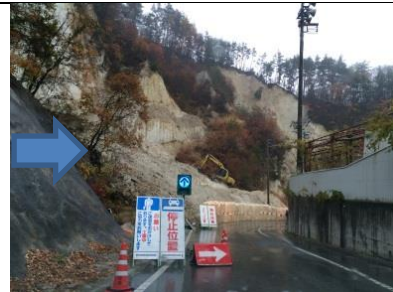
(写真) 長野県神城断層地震(H26.11.22)における道路啓開作業
