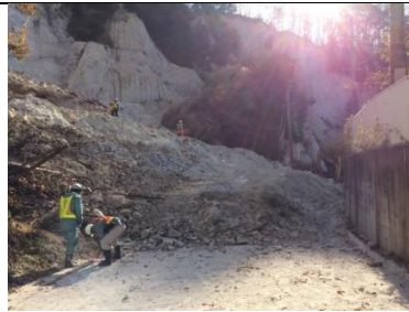
(写真) 長野県神城断層地震(H26.11.22)における道路啓開作業
