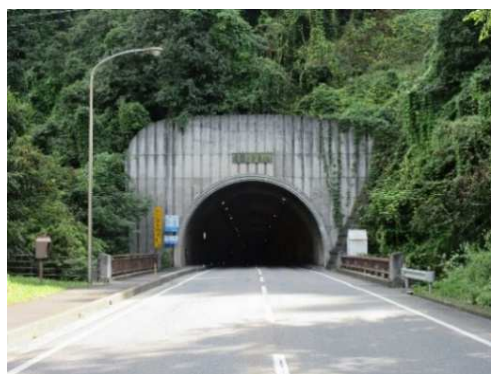
日高トンネル（長野市）
