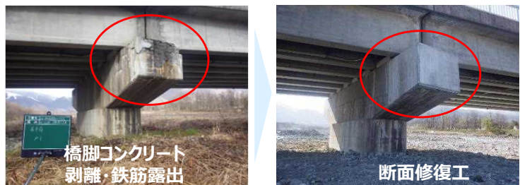
(国)148号 北安曇郡白馬村 松川橋
