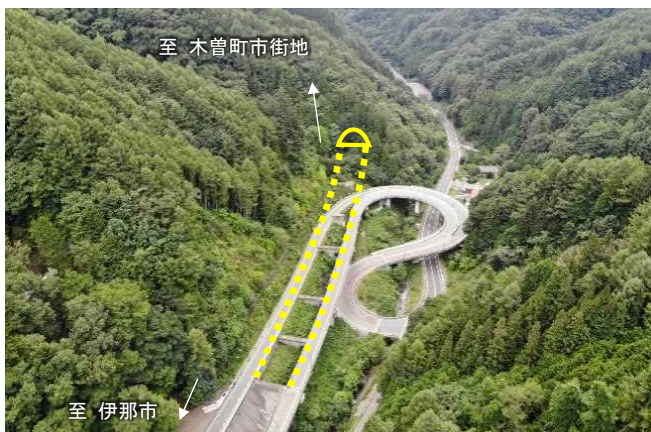
伊那木曾連絡道路(姥神峠道路(延伸))
