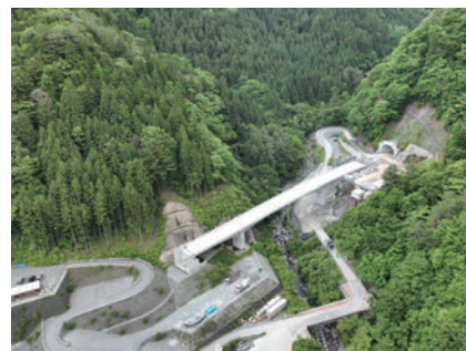
（仮称）青崩峠トンネル工事写真
