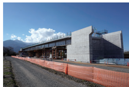
扇子田公園付近橋梁工事写真
