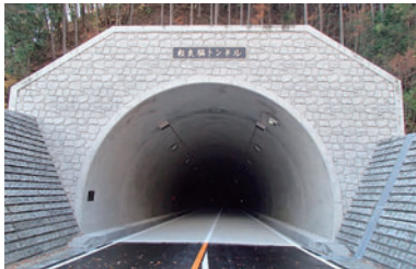
(国) 151号 下條村 粒良脇トンネル
