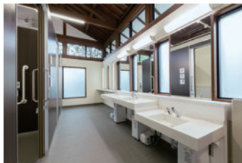
道の駅トイレリニューアル実施状況
