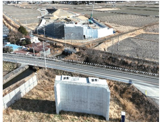
新村高架橋 工事中(松本市)
