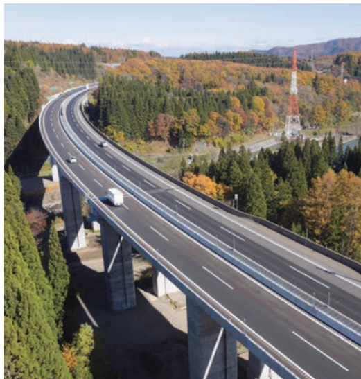
新潟県境の「れいめい橋」
