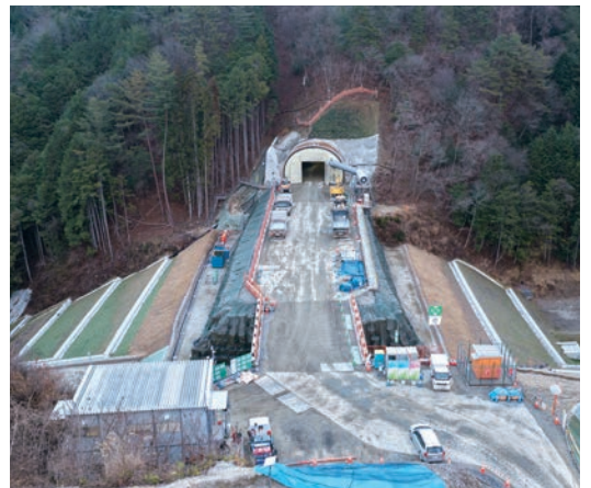
飯喬道路 2号トンネル 工事中(喬木村)
