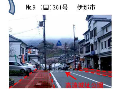
歩道の段差解消
