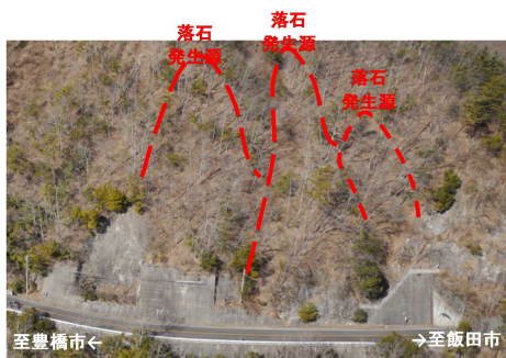
図 3:落石等危険の恐れがある道路法面の調査イメージ (国道 151 号阿南町落合)
