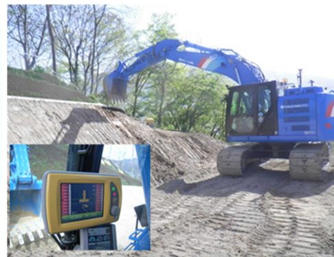
ICT 活用工事の例 (マシンガイダンス掘削工事)
