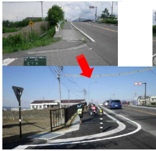
波打ち歩道の改善事例 (国道403号須坂市幸高)
