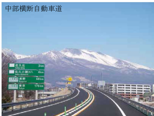
写真1: 県土の骨格となる高規格幹線道路の例
