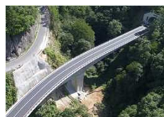
緊急輸送路の整備(バイパス)
