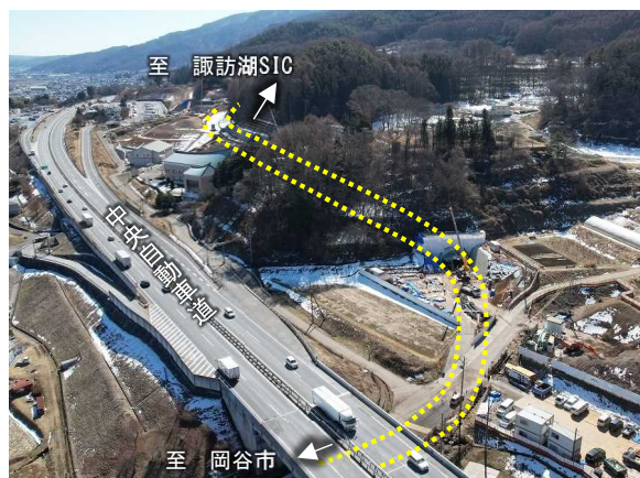
(主)諏訪辰野線 岡谷市～諏訪市 小坂～有賀 (平山トンネル施工状況)
