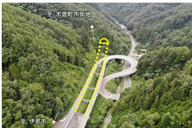
伊那木曾連絡道路(姥神峠道路(延伸))
