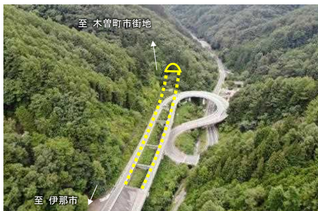
伊那木曾連絡道路(姥神峠道路(延伸))
