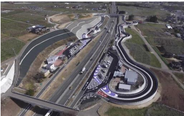
座光寺スマートインターチェンジ（飯田市）
