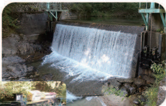
黒川の取水堰堤
