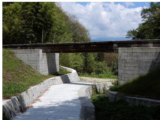
【水路橋の耐震補強（飯田市）】
