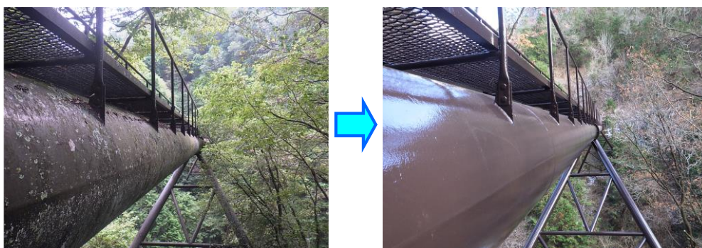
補修が完了した生田寺沢川サイフォン（竜東一貫水路）
