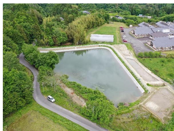
【ため池堤体の耐震改修（阿南町）】
