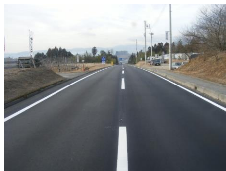
傷んだ路面を県営農道整備事業で改良（広域農道伊那南部2期地区）
