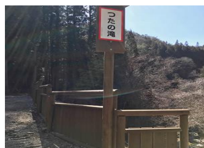
【案内看板・遊歩道柵の設置】
