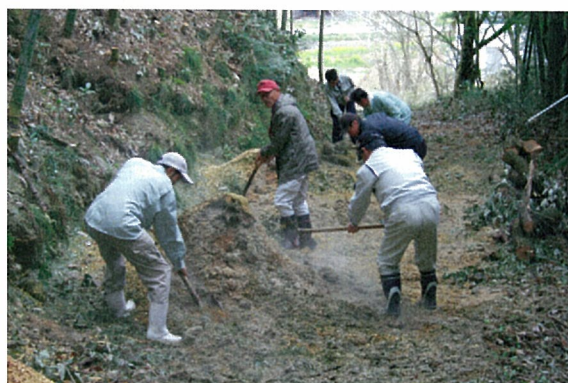
【伐採した竹をチップ化し敷き均しを行う】
