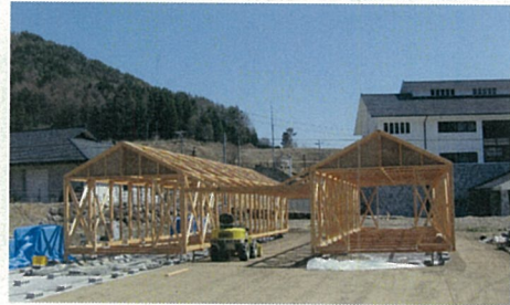
【ビニールハウス設置状況】
