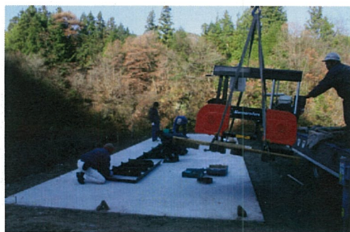
【製材機設置の様子】
