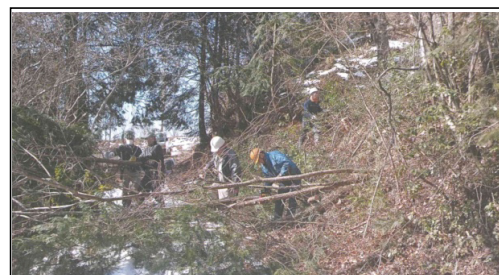
【樹木整備作業状況】
