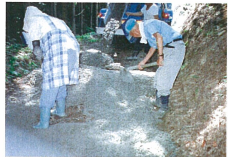
地域住民によるコンクリ舗装作業風景
