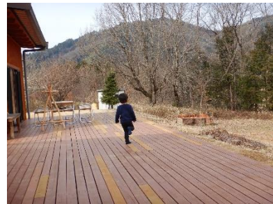
【ウッドデッキ修繕】
