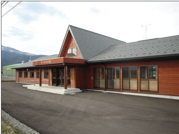
全 景 (外壁 サワラ)
