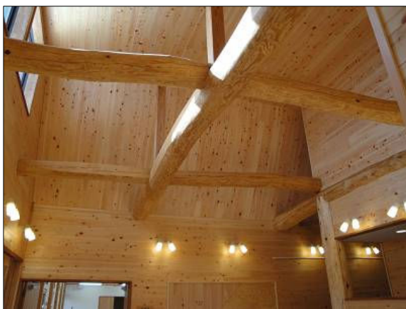
ホール天井 (化粧梁 アカマツ)
