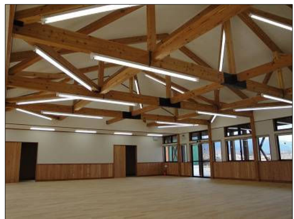
会議室 (柱・梁・桁・腰壁 カラマツ)
