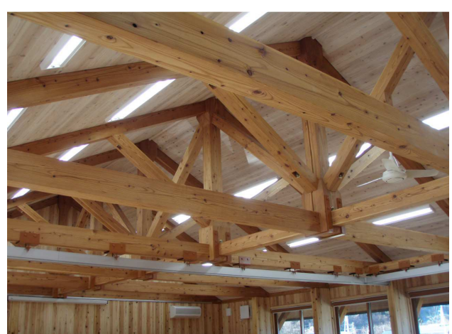
会議室小屋組み
