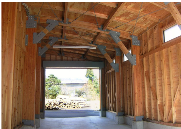
機械保管庫内部
