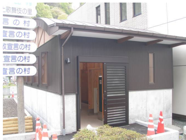
公衆トイレ外観
