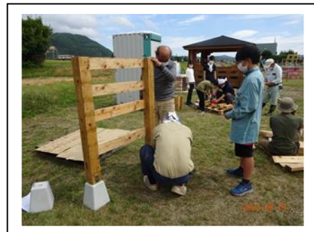
【テーブル、椅子等の組立て作業】
