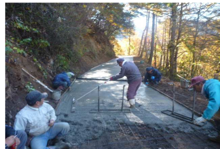
【舗装工事風景】
