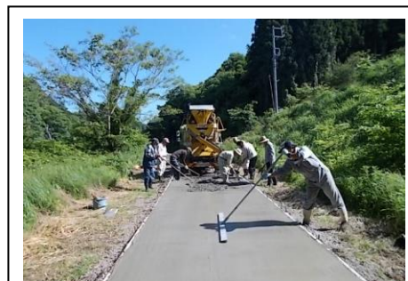
【協働で行う生コン作業】
