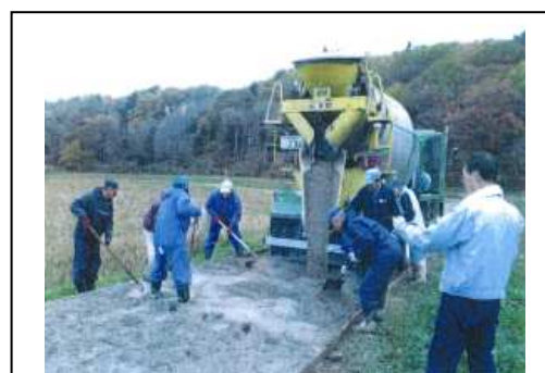
【生コン舗装作業中】
