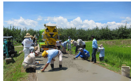
【協働で行う生コン打設作業】
