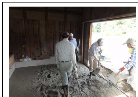
【コンクリート流し込み】
