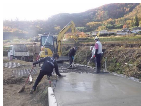
【舗装工事風景】
