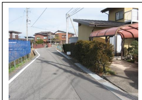
【水路改修事業】
