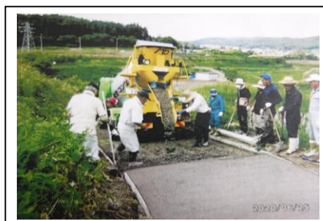
【協働で行う生コン作業】
