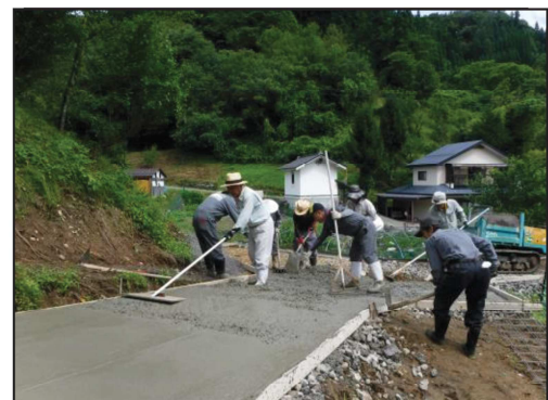
【初引地区 (初引) での作業】
