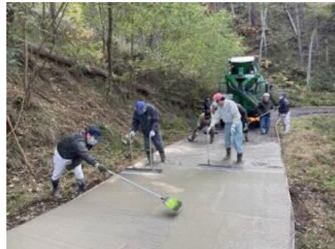
【舗装工事風景】
