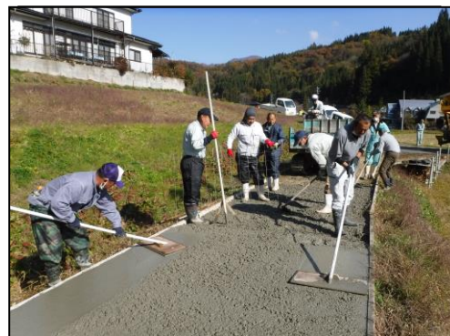
【夏和地区 (鴨之尾) での作業】
