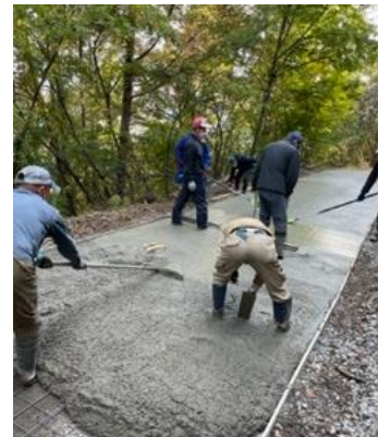
【舗装工事風景】
