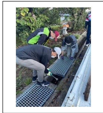
【水路改修事業】
