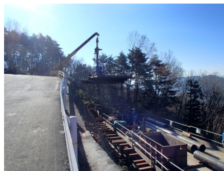
(杭工工事中の状況)
