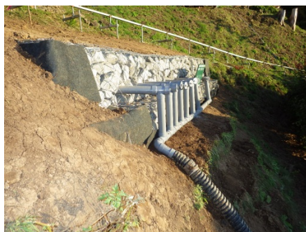
(工事完成後の状況)
