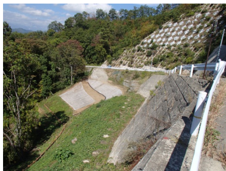
(工事完成後の状況)
