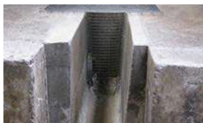
排水溝の侵入対策
