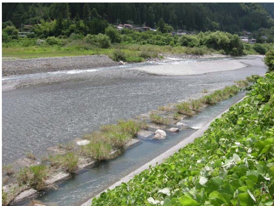
出水前の八重河内川合流部付近の様子
