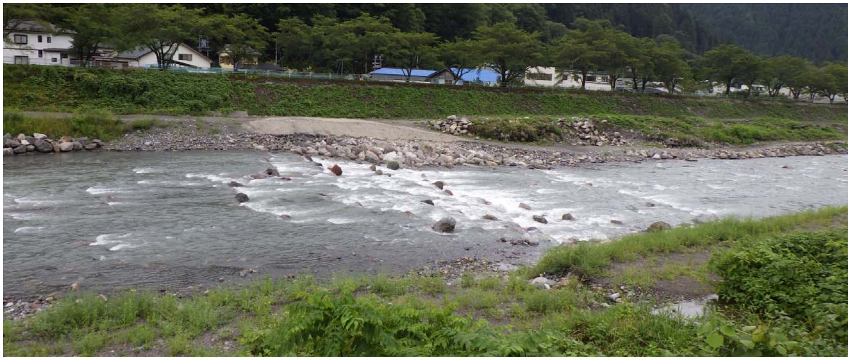
中橋下流帯工の全景
