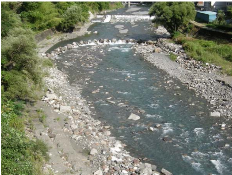
出水前の中学校前の帯工付近の様子
