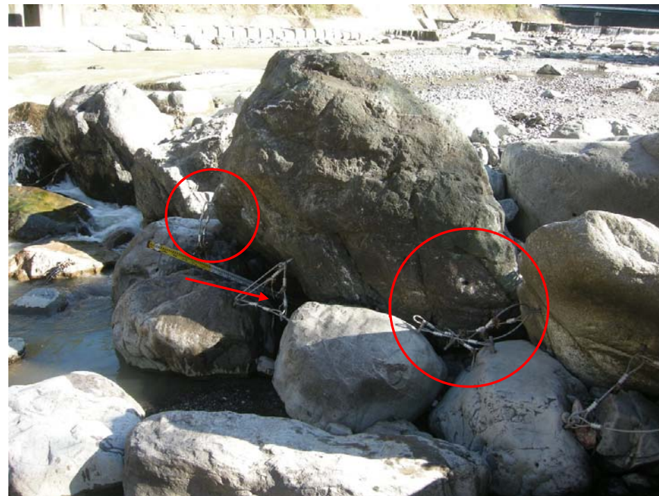
帯工の落差部分の力石に連結されていた太いアンカーは抜けが目立ち、巨石の間の砂礫はほとんど流出していた。(赤矢印の箇所)
