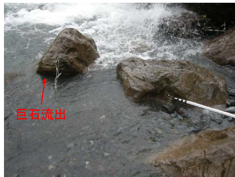
移動・流出した巨石の様子
