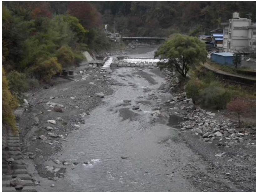
工事直前の状況
