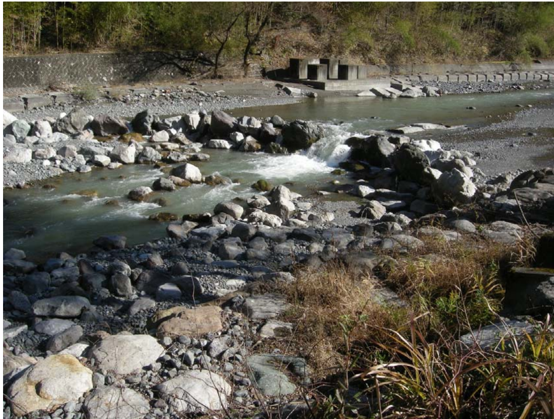
出水後（12月9日）の状況
