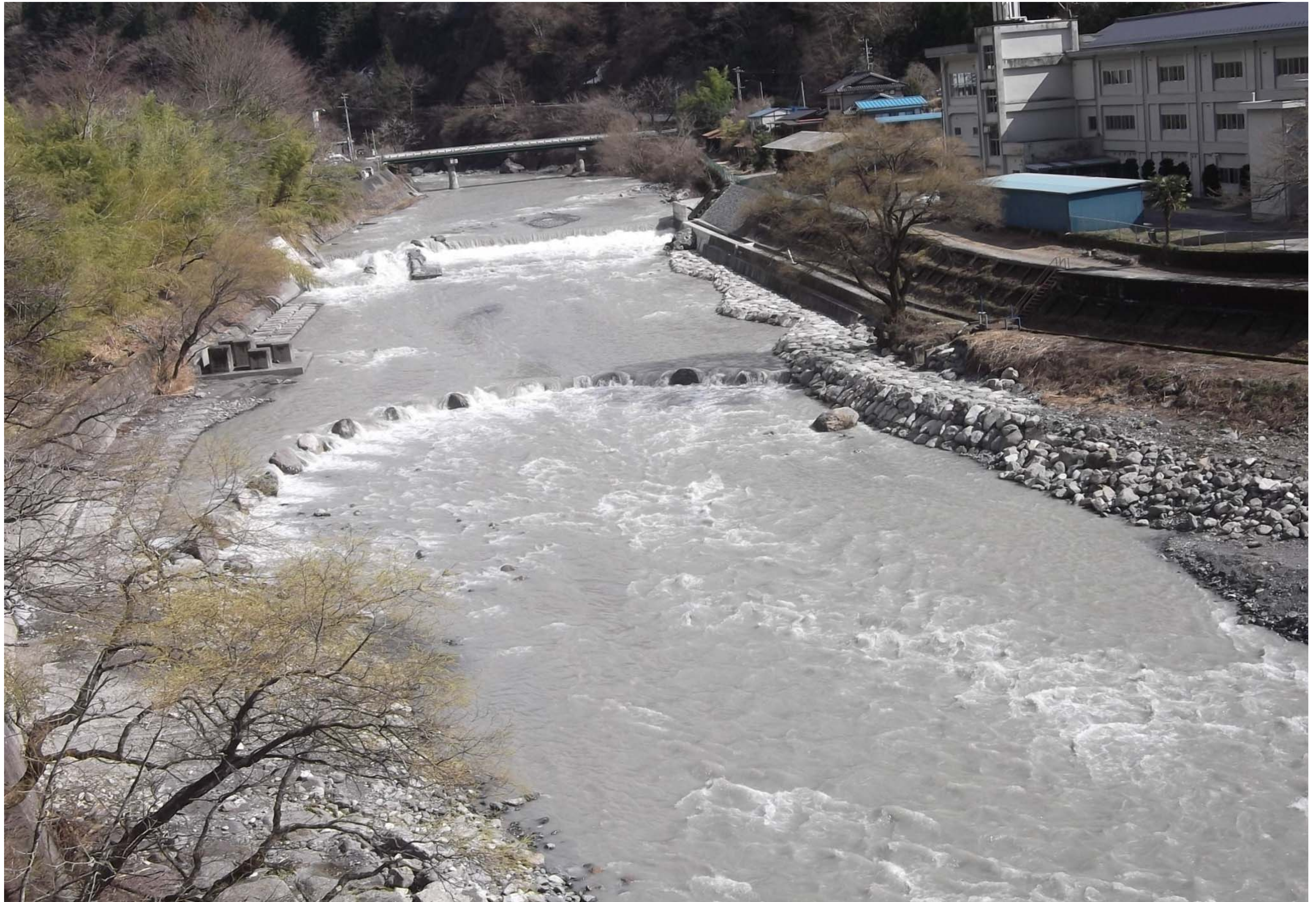
中学校横 工事完成(平成26年3月27日)
