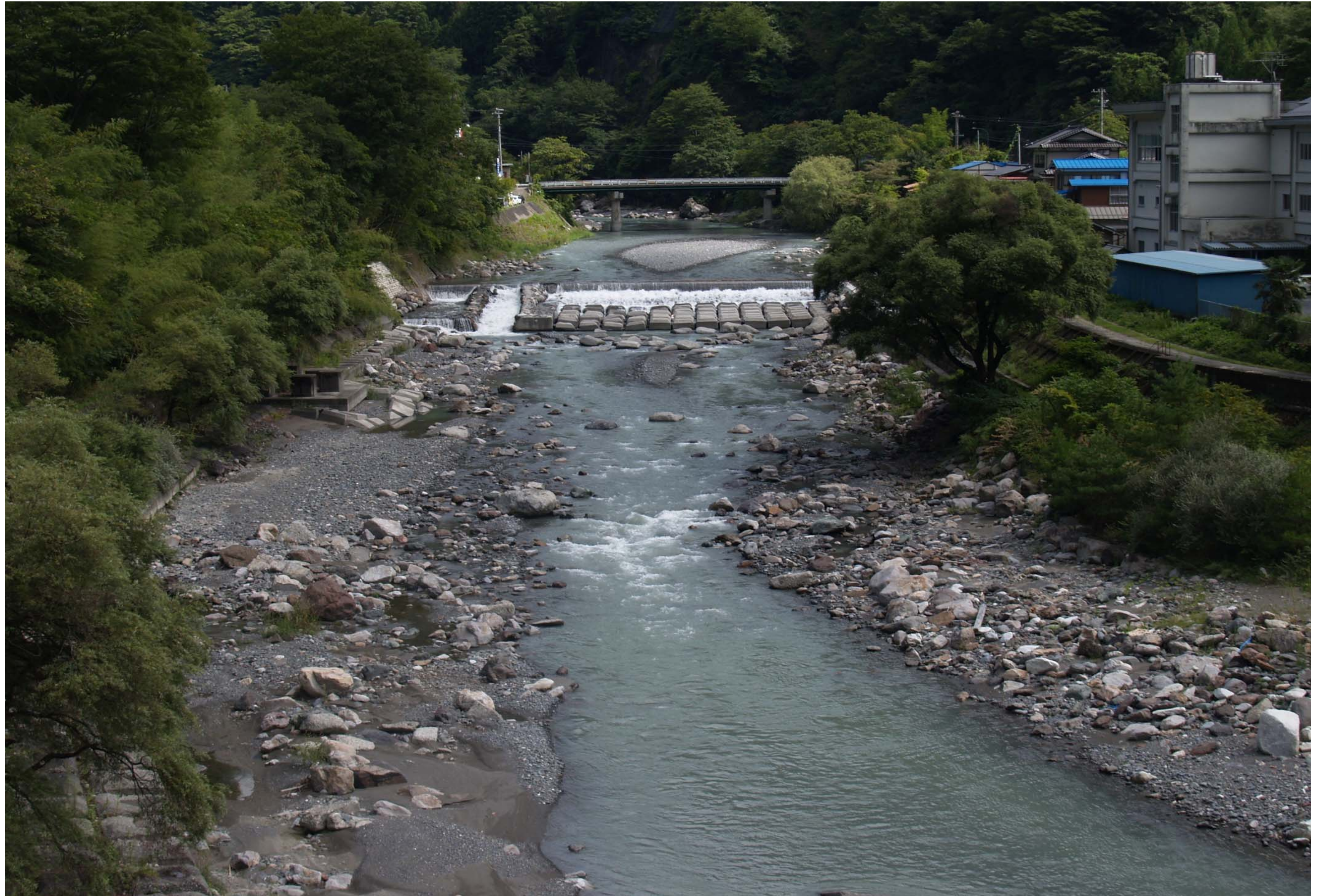
中学校横 工事着手前の状況
