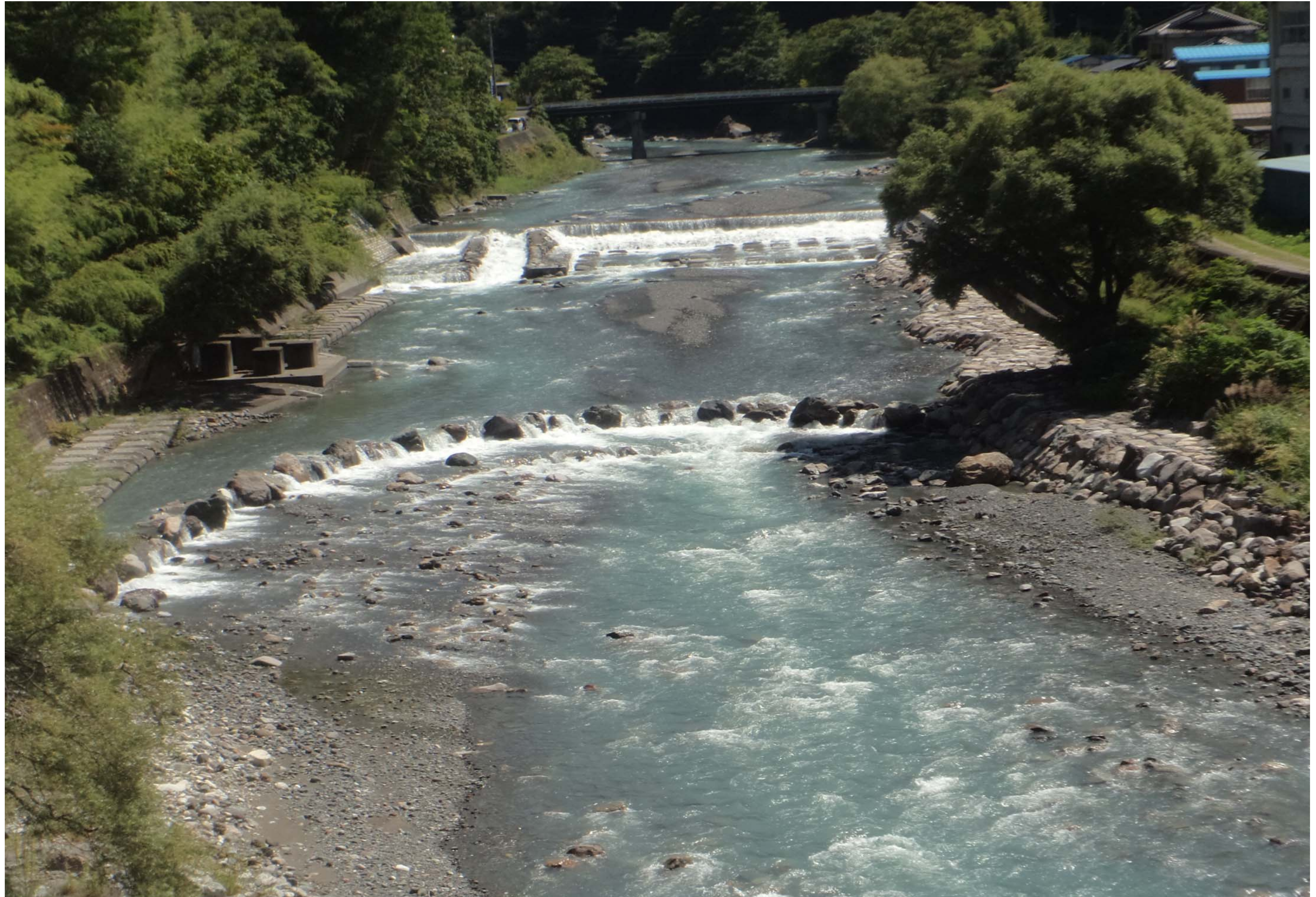
中学校横 工事完成後(平成26年9月9日)
