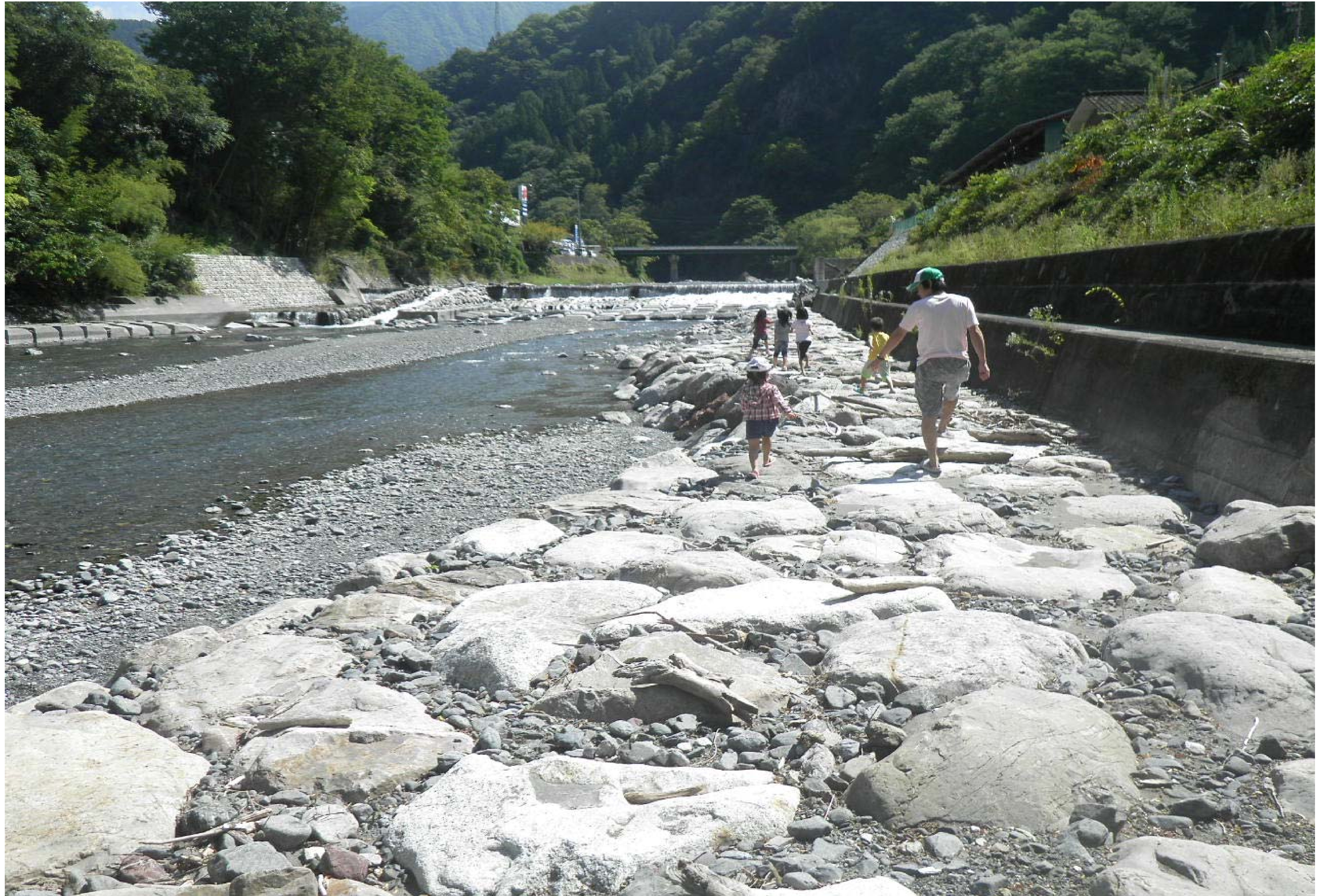
中学校横 工事完成後(川辺で遊ぶ親子)
