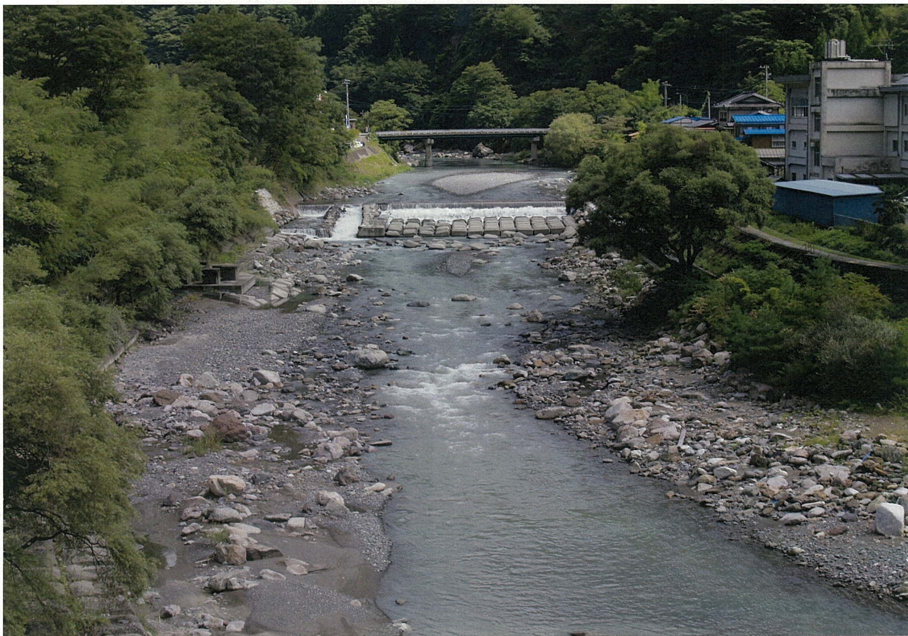
中学校横 工事着手前の状況
