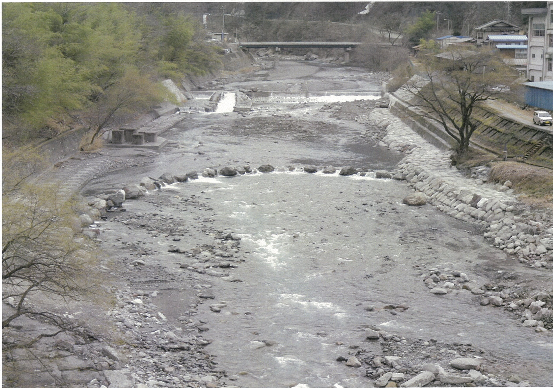
中学校横 工事完成(平成26年3月)
