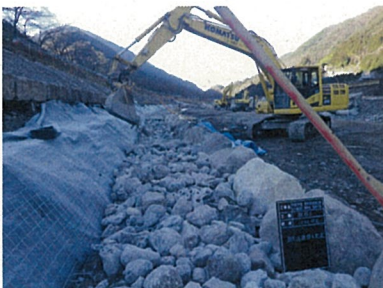
⑦ 胴込材の投入。充填状況。
