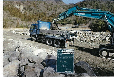
③ 不足土は名古屋山工区から土砂等運搬します。
