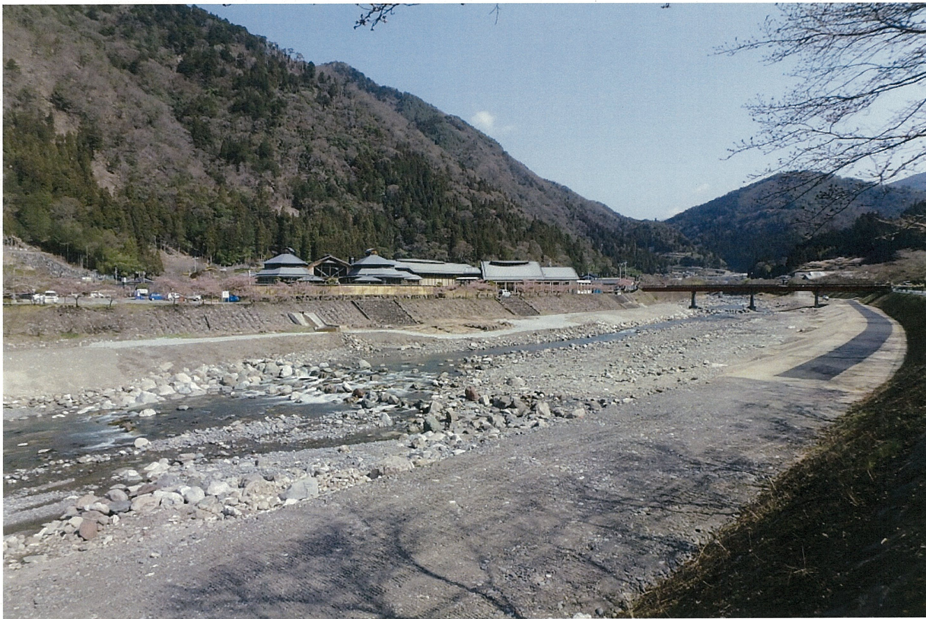
かぐらの湯横 H27.3月(工事中)
