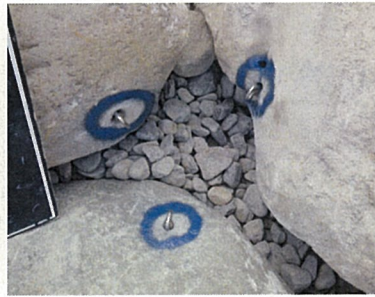
⑬ ASアンカー径14mm L=81mm打設状況。
