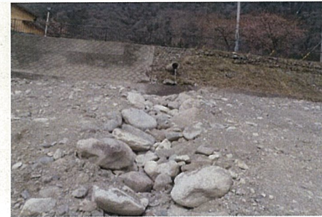
排水管の流末処理として石積みを施工しました
