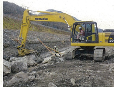
③ 根石の据付を行います。
