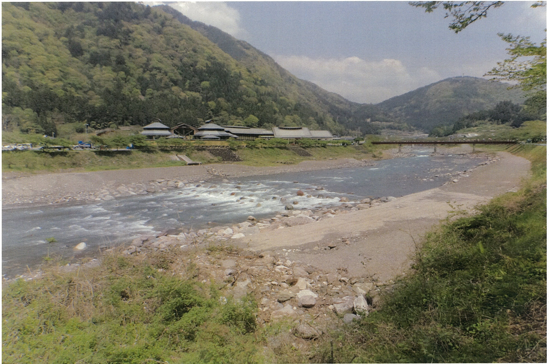
かぐらの湯横 帯工完成後2ヶ月経過(H27.5月)
