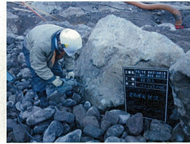
④ φ10.5mmのドリルで30～40mm程度穿孔致します。
