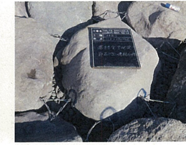
⑭ 巨石1個に対して6箇所連結を行います。⑮ 終わりに天端に胴込材を投入し完了となります。
