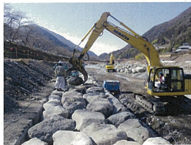
⑪ 天端に巨石を据付けます。
