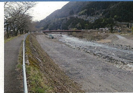
⑦ 左岸側完成(上流から下流へ)
