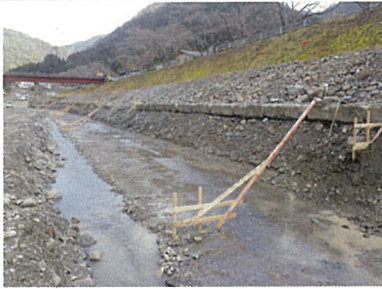
① 床堀並びに法面整形完了。
