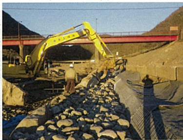
⑧ 2段目の巨石の据付を行います。
