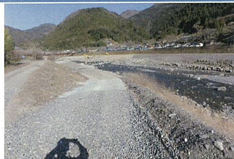
右岸側完成(起点側から)
