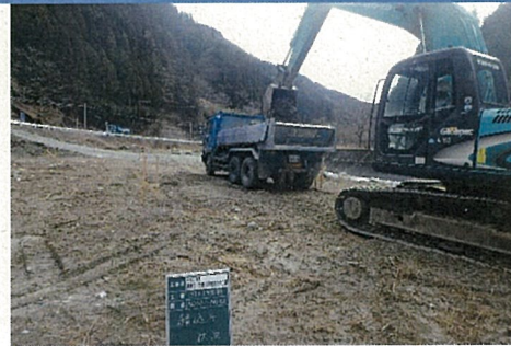
② 老の林工区から土砂等運搬します。
