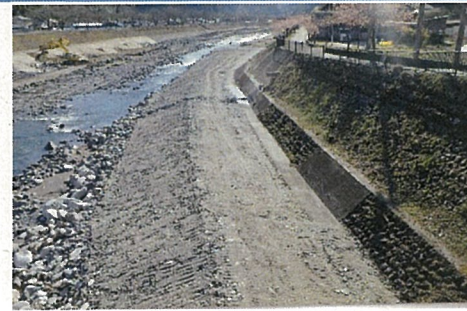
右岸側完成(中橋から下流へ)
