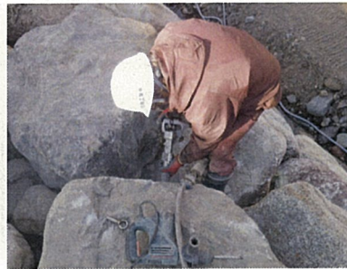
⑫ ジャックハンマーにて巨石を35mm穿孔致します。
