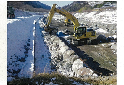
⑩ 天端の巨石の据付を行います。
