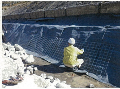
② 吸出し防止材、背面ネットを設置します。
