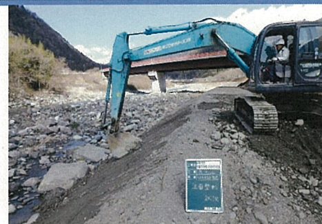
⑥ 法面整形を行います。
