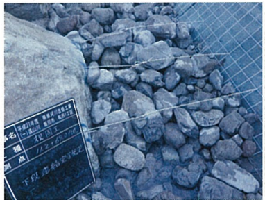
⑥ アンカーとシャフトによって背面金網と連結します。
