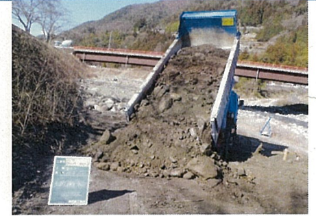
④ 和田2工区へ土砂等搬入を行います。
