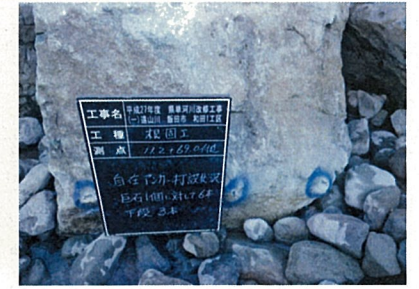
⑤ 自在アンカーは巨石1.0m以上は6本打設を行う。
