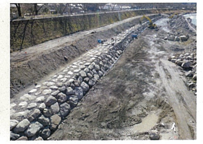
⑭ 巨石1個に対して6箇所連結を行います。⑮ 終わりに天端に胴込材を投入し完了となります。
