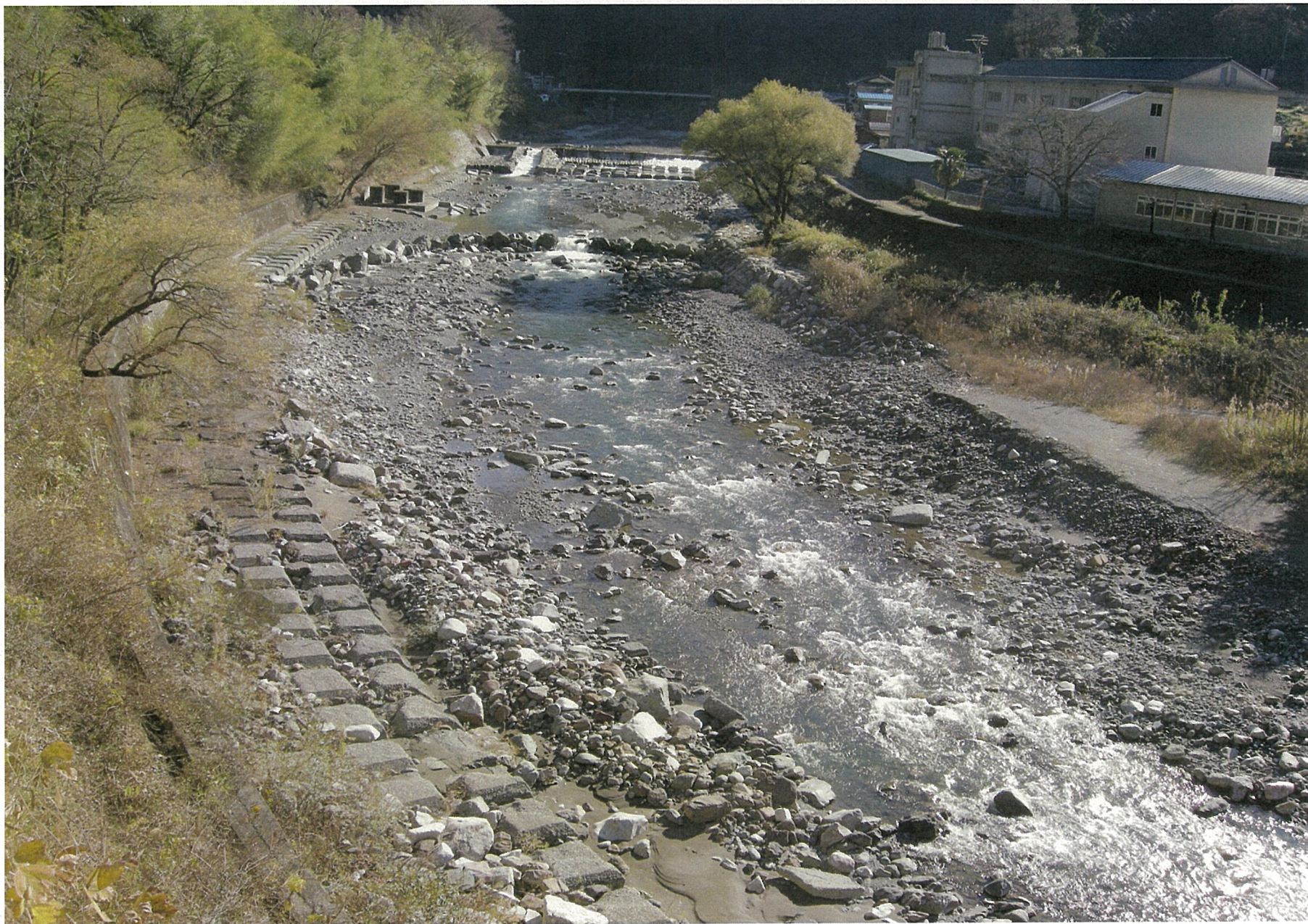
中学校横 工事完成後約2年経過後(渇水期)
