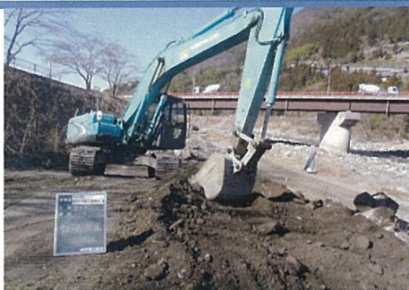
⑤ 重機にて敷き均しを行います。
